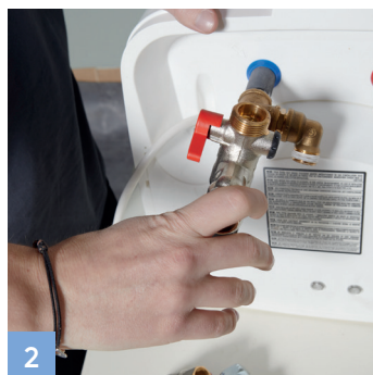
2 Monter les raccords hydrauliques
