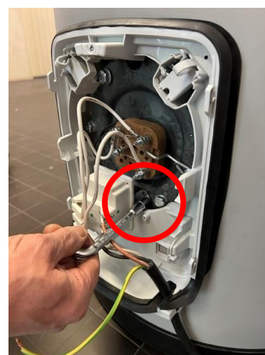
5.4 Dévisser la vis de maintien du thermostat (clé à pipe 8 ou tournevis plat)
