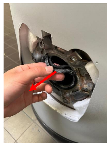
5.13 Retirer le joint à lèvre du chauffe-eau
