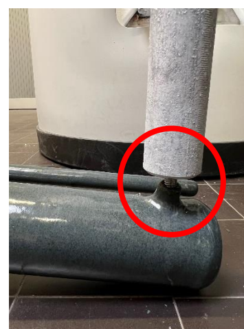
7.3 Visser l'anode au bout du corps de chauffe
