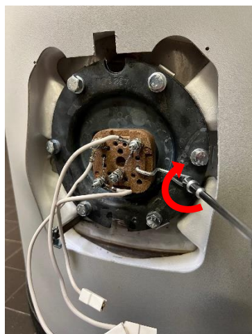
7.10 Visser la patte fil sur le corps de chauffe (clé à pipe 8 ou tournevis plat)
