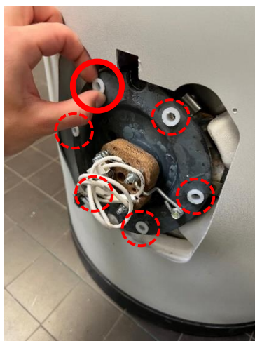
5.11 Retirer les 6 entretoises d'isolation du corps de chauffe
