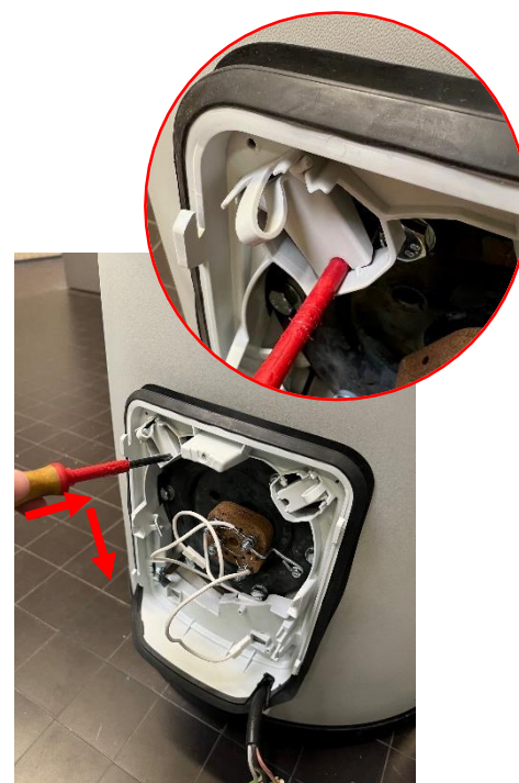
5.7 Ouvrir les 2 pattes de fixation du capot fixe à l'aide d'un tournevis
