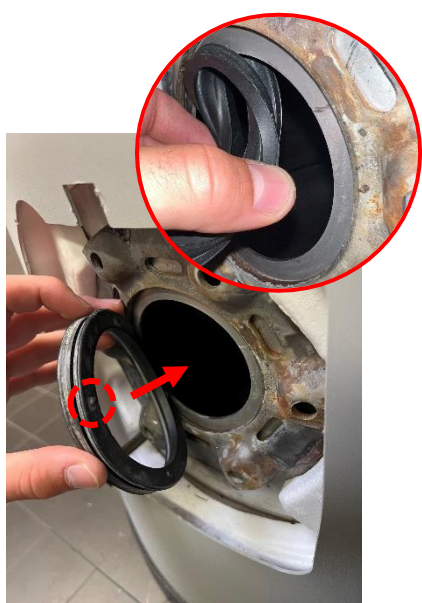
7.1 Placer le joint à lèvre sur l'ouverture du chauffe-eau (face avec 4 picots à l'intérieur)
