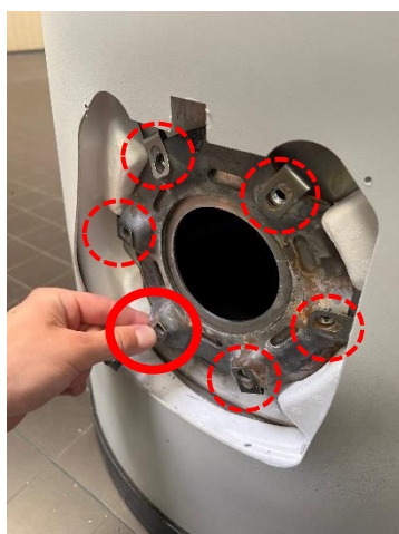
5.14 Retirer les 6 écrous cage de la contre-bride (si endommagés)
