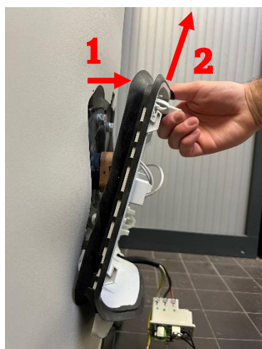
5.8 Tirer puis soulever le capot fixe pour le retirer
