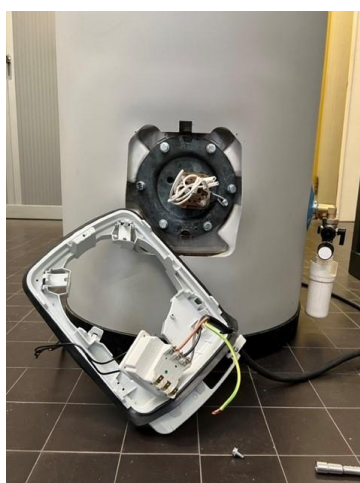
5.9 Poser le capot fixe à côté du chauffe-eau avec le thermostat câblé
