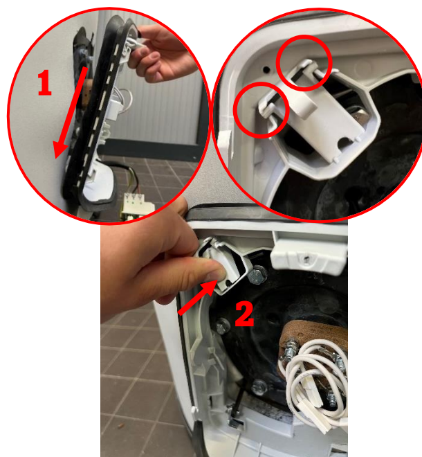
7.11 Placer et fixer le capot fixe sur le chauffe-eau à l'aide des pattes de fixation
