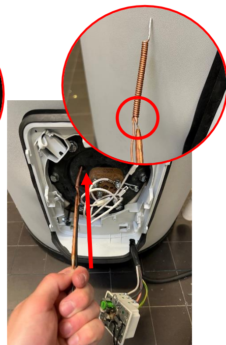
7.12 Placer les bulbes du thermostat dans le doigt de gant du corps de chauffe
