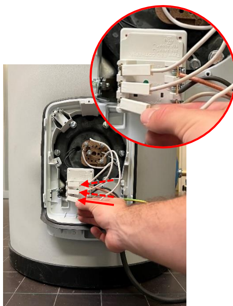
7.14 Connecter indifféremment les cosses faston de la stéatite sur le thermostat
