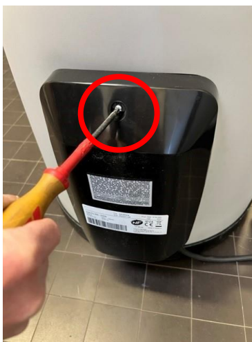
5.1 Dévisser le capot mobile (tournevis PZ2)
