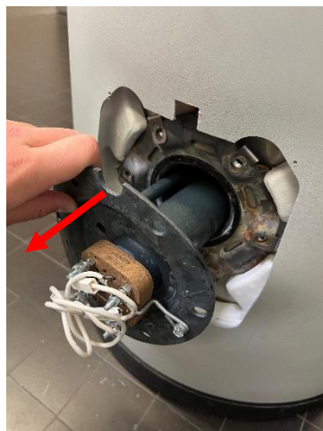
5.12 Sortir le corps de chauffe du chauffe-eau
