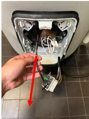
5.6 Retirer les bulbes du thermostat du corps de chauffe
