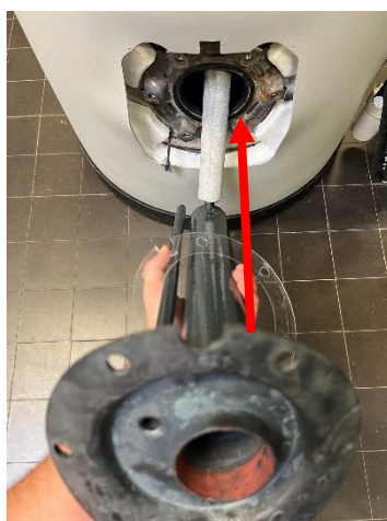
7.5 Placer le corps de chauffe dans la cuve (d'abord l'anode, puis le corps de chauffe en l'inclinant)
