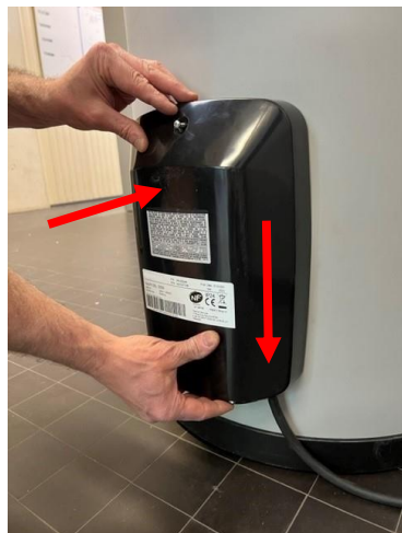
8.1.8 Plaquer puis glisser le capot mobile
