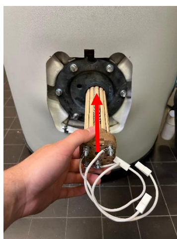
7.8 Placer la stéatite dans le corps de chauffe
