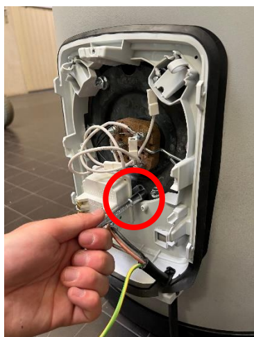
7.13 Visser le thermostat sur la bride du corps de chauffe (clé à pipe 8 ou tournevis plat)
